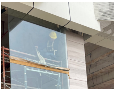
图10 整体式托运吊装，局部调整，滑移就位
