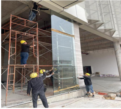
图9 整体式托运吊装
