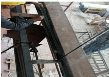
图11 弹性垫块安装
