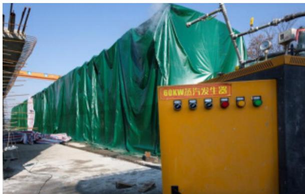
图2 蒸汽发生器养护
