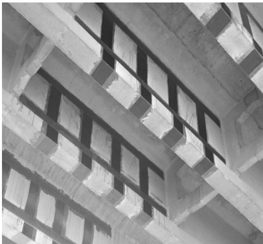
图2 粘贴碳纤维加固处理
