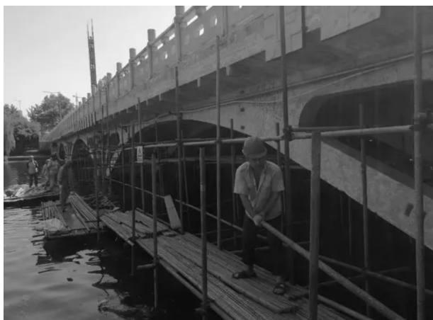
图1 桥梁基础加固
