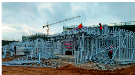
图1 轻钢装配式住宅建设现场
